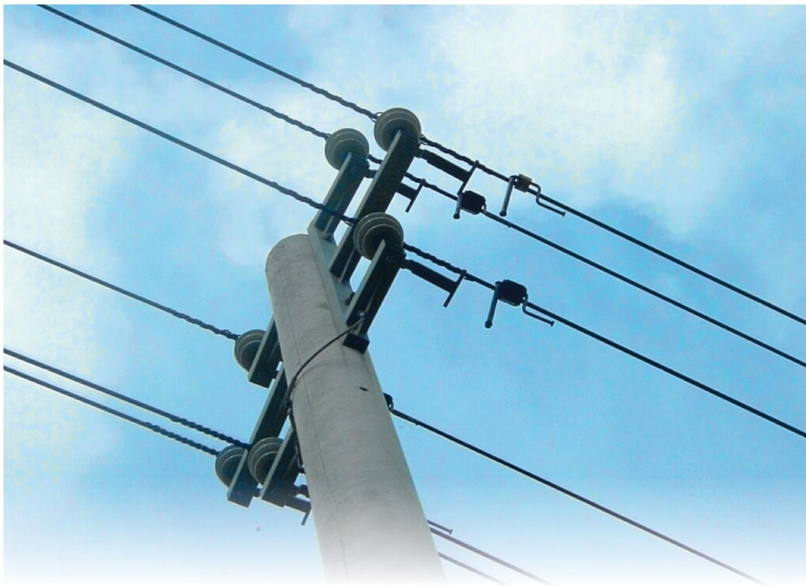
**Книга 4. Система защищенных проводов напряжением 6-20 кВ
