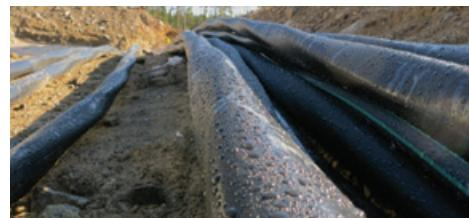
Двухслойная. Поверхностный слой полиэтилена высокой плотности толщиной 0,5 мм и основной слой толщиной 3,5 мм полиэтилена низкой плотности, который демпфирует механические воздействия. Таким образом, кабель является механически прочным и одновременно гибким. Данная оболочка в 4–5 раз прочнее, чем стандартная оболочка.
