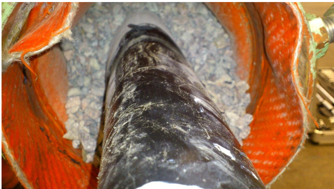
Рис. 7 Кабель в трубе с заполняющим материалом вокруг него
