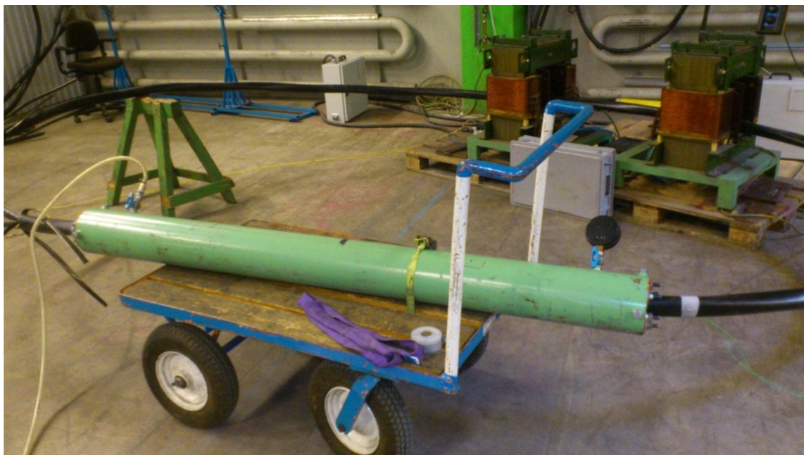
Рис. 6 Труба с кабелем внутри и трансформаторами тока для его нагрева
